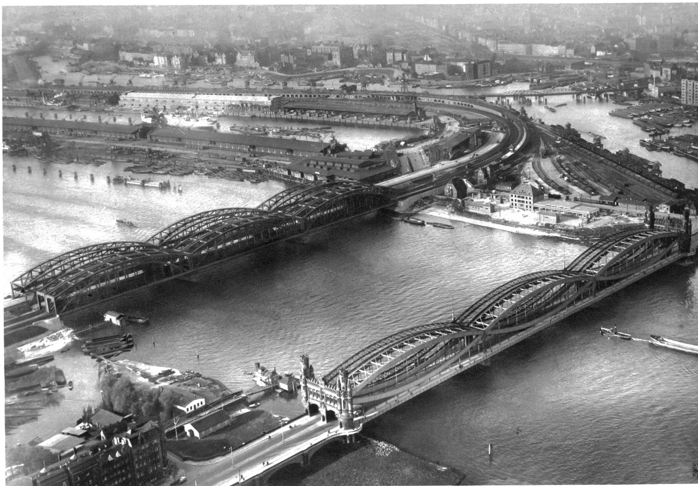
Hamburg, Blick auf die Elbebrücke
