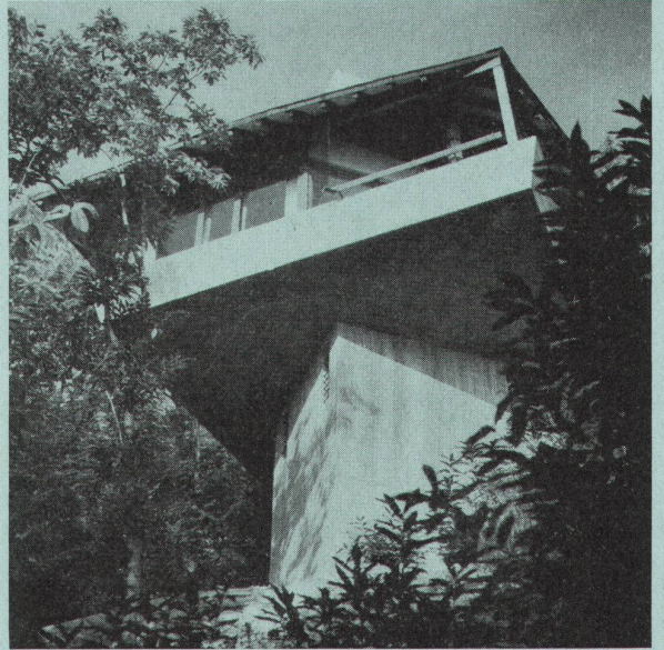
Aus der Häusergruppe Tre Tetti, Locarno-Monti. Architekt: Manuel Pauli BSA, Zürich
