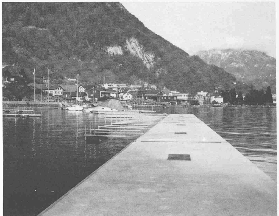
Hafenanlage in Gersau, Mole 4 m breit
