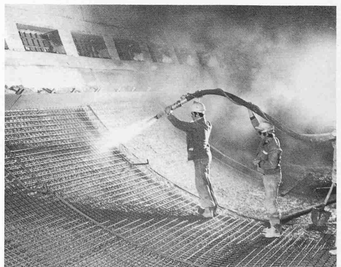
Bild 4. Los West: Erstellen des Spritzbetonsohlge- wölbes
