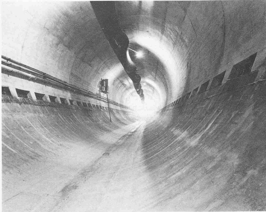
Bild 5. Los West: Der Kieskoffer ist entfernt; mit der Abdichtung der Tunnelsohle kann begonnen werden
