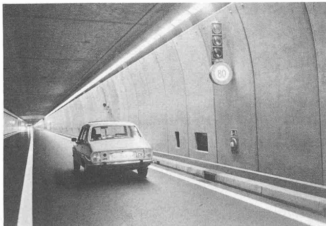
Bild 2. Beleuchtung der Mittelzone
