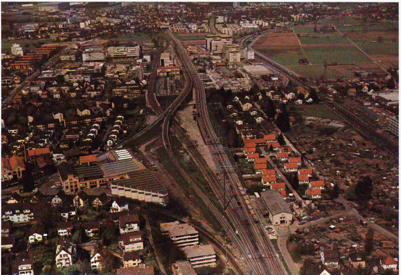
Bild 1. Brückenbauten im Oberhauserried
