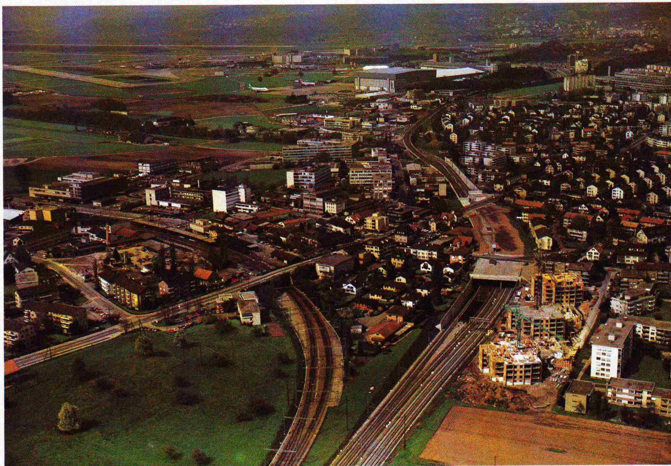
Bild 2. Blick von Süden auf den teilweise überdeckten Bahneinschnitt mit Station Opfikon an der Klotenerlinie und den Bahnhof Glattbrugg (links) an der Bahnlinie nach Bülach (Bauzustand 1979)
