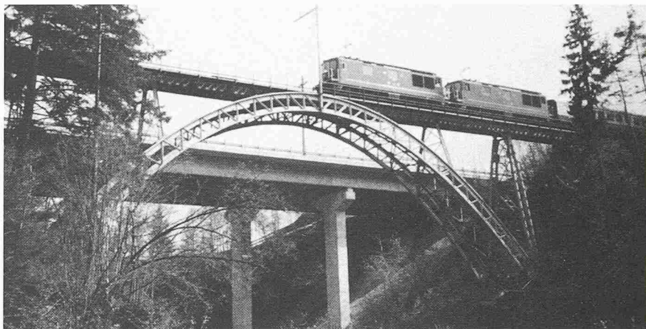
Kanderbrücke bei Wimmis mit zwei BLS-Lokomotiven. Die Ästhetik des eleganten Bogens wird leider durch die neue Betonbrücke mit brutal in das Tobel gestellten Stützen beeinträchtigt
