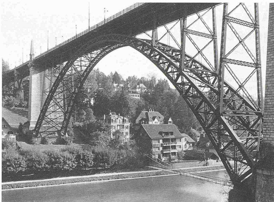
Die Kornhausbrücke in Bern, erbaut 1895–1898, Stahlgewicht 1815 t
