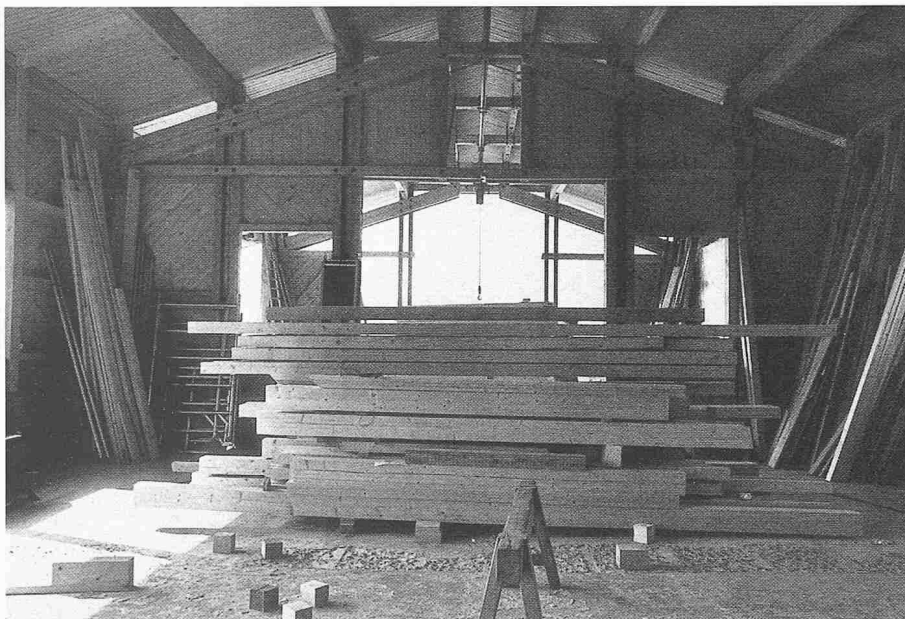
Bild 3. In der Abbundhalle des Zimmermanns liessen sich die nicht visuell erfassbaren Holzcharakteristika mit einem geeigneten Hilfsgerät überprüfen
