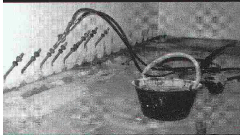
Elastische Abdichtungs-Injektion-Rascolflex in einer Zivilschutzanlage.
