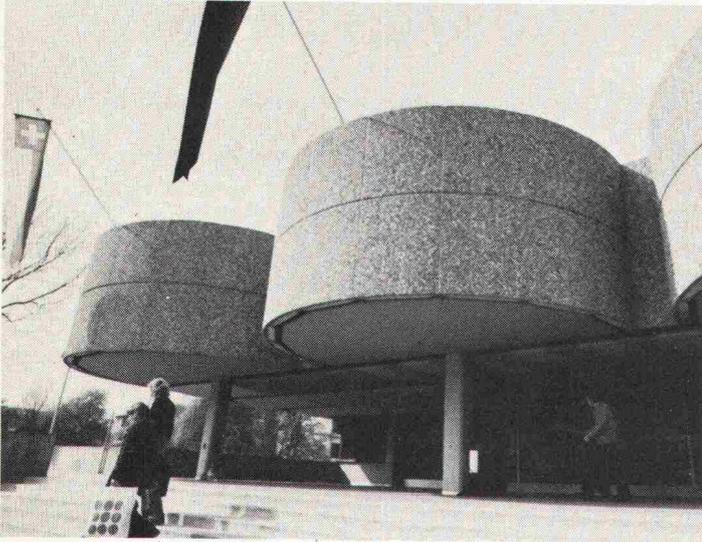
DURISOL-Fassadenelemente sind dreischichtig. Ein hochisolierender Kern wird beidseitig von einer Feinbetonschicht umschlossen. Durch ein besonderes Härtingsverfahren erhält die Aussenschicht ihre Wetterbeständigkeit und die helle Tönung. Sie wird weder gestrichen noch sonstwie behandelt, kann aber auch in Rippenbeton-, Wasch-
