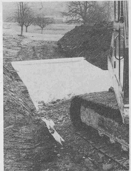
Detail aus der Baupiste. Das Geotextil ist ausgelegt. Der Bagger fährt bis an das Schüttungsende, um neues Material aufzuschütten
