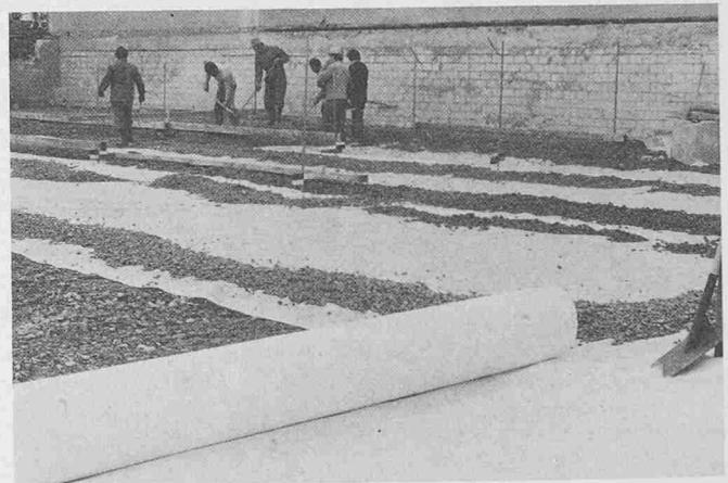
Oben: Gesamtübersicht der Arbeiten mit verwobenen Polypropylen-Bändchen in einer Baugrube. Das Geotextil wurde streifenweise zur Fixierung mit Kiesbeton bedeckt, anschliessend wird eine starke Lage Kiesbeton = Drainageschicht eingebaut
