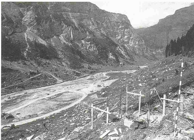
Die Panixer Alp 1986 zur Zeit des Baubeginns der Talsperre (Bilder: Comet)
