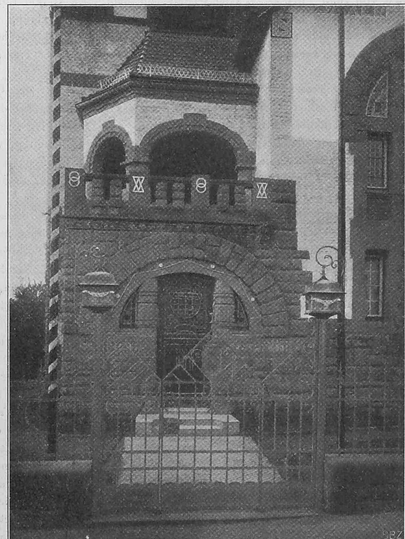
Abb. 3. Ansicht des Haupteingangs
