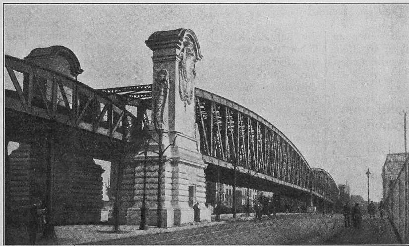
Abb. 8. Ueberbrückung der Nordbahn.
