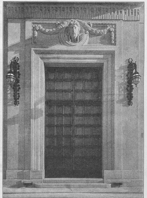
Abb. 6. Ansicht des Hauptportals.
