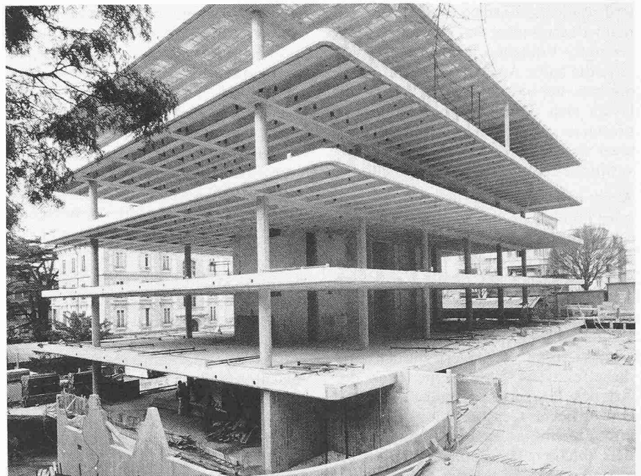
Hochbaustützen in einem Geschäfts- und Bürohaus in Lausanne
