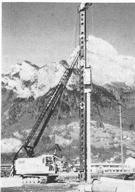
Pfähle für Brückenfundation (Sargans/SG)
