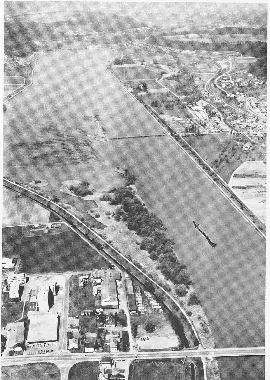
Bild 3. Stand der Verlandung im Stausee Klingnau. Der Fluss restauriert gewissermassen sein Bett – allerdings auf einem um den Stau höheren Niveau (Foto Comet 1975)
