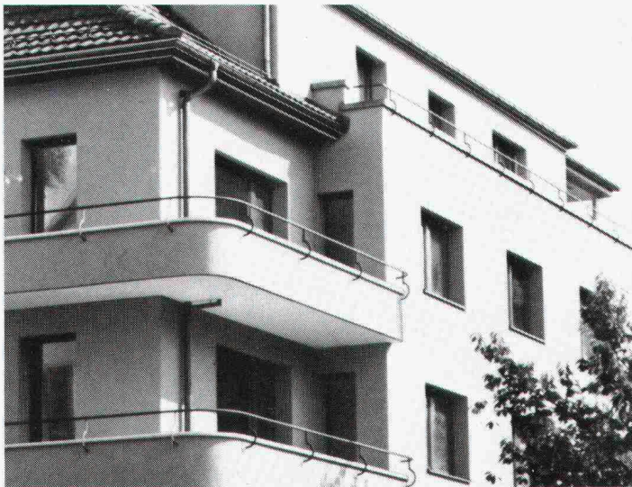
- Mehrfamilienhaus-Sanierung, Dübendorf. 1980. Aussenisolation.
