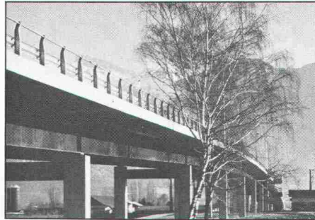
Strassenbrücke in Verbundbauweise Stahl/Beton
