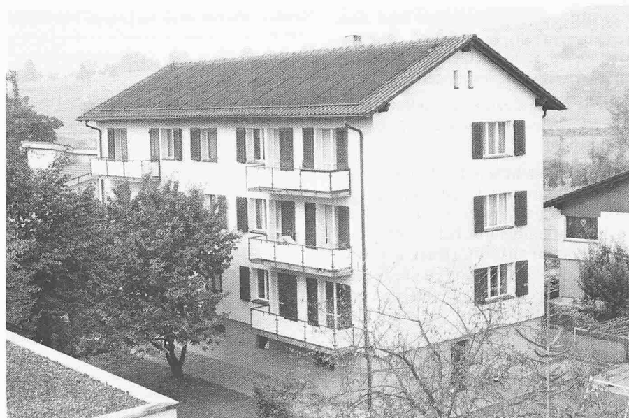
Die Projektliegenschaft in Baar (Kt. Zug)
