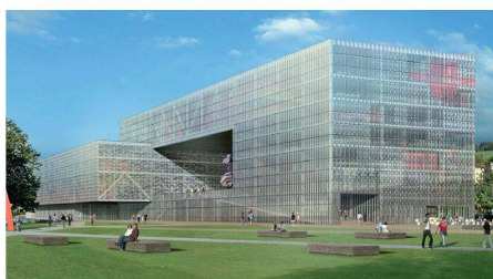
03 «Seebühne»: Das verglaste Ensemble besteht aus drei verketteten Bauten. Das stehende Kettenglied beherbergt die Kongress- und Konferenznutzung (KCAP Architects & Planners)
