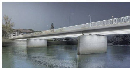
04 «Neptune»: Der als Verbundkonstruktion ausgebildete Oberbau besteht aus vier stählernen Längsträgern und einer Fahrbahnplatte in Ortbeton. Die Träger sind auf den Pfeilern fest, auf den Widerlagern beweglich gelagert. Die Pfeiler werden in Fortsetzung der heutigen Form erhöht
