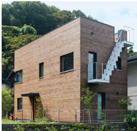
01 Das erste Passivhaus Japans ist eine zwei-stöckige Holzkonstruktion mit Dachterrasse (Fotos: Key Architects)
