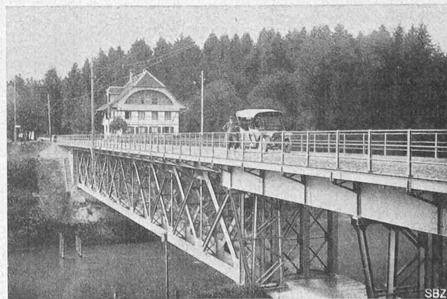
Abb. 15. Ansicht vom rechten Ufer des Hagneck-Kanals.
