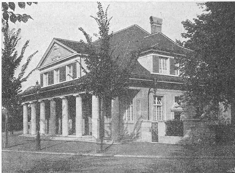
Abb. 2. Polizeiposten am Wielandplatz in Basel.
