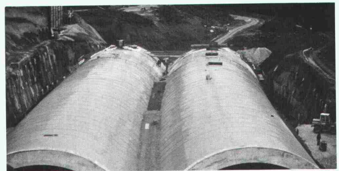
Tunnel Aichelberg, Autobahn A8 Karlsruhe-München, abgedichtet mit 7000 m 2 Sarnafil Typ FP 4 mm.
