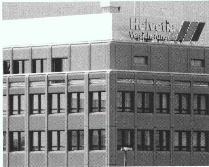
Geschäftshaus Helvetia-Unfall Zürich
