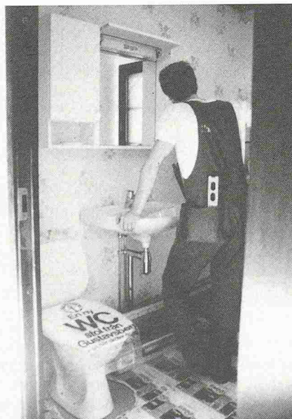
Bild 3. Installations- und Apparateeinbau im Werk
