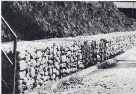
Beispiel einer Böschungverbauung
