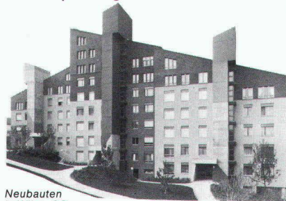
Neubauten in Wilen, SG. Überbauung mit Holz/IV-Fenstern.
