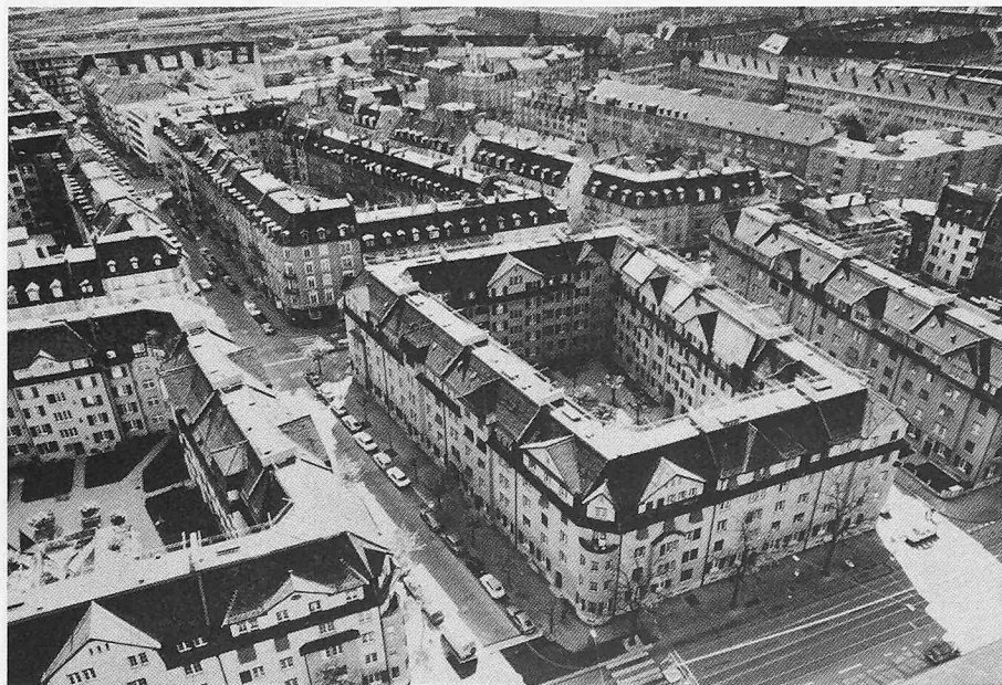
Überblick über die Wohnkolonie Limmatstrasse, Zürich
