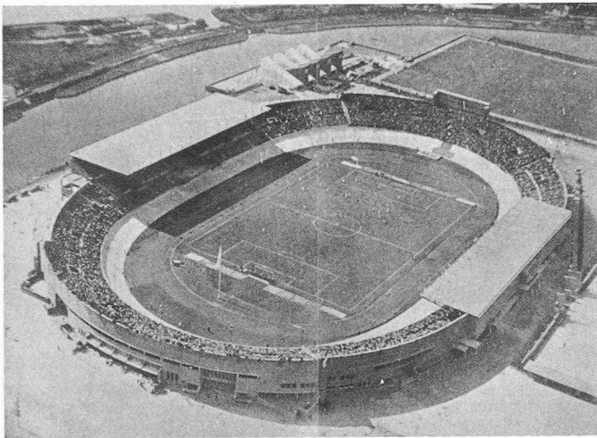
Bild 16. Olympia-Stadion in Amsterdam, 1928. Stadion als Bestandteil eines Sportparks
