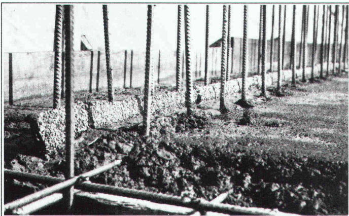
Erstellen einer Anschluss-Dichtung "BFL-MASTIX" Typ 20/70 R4.
