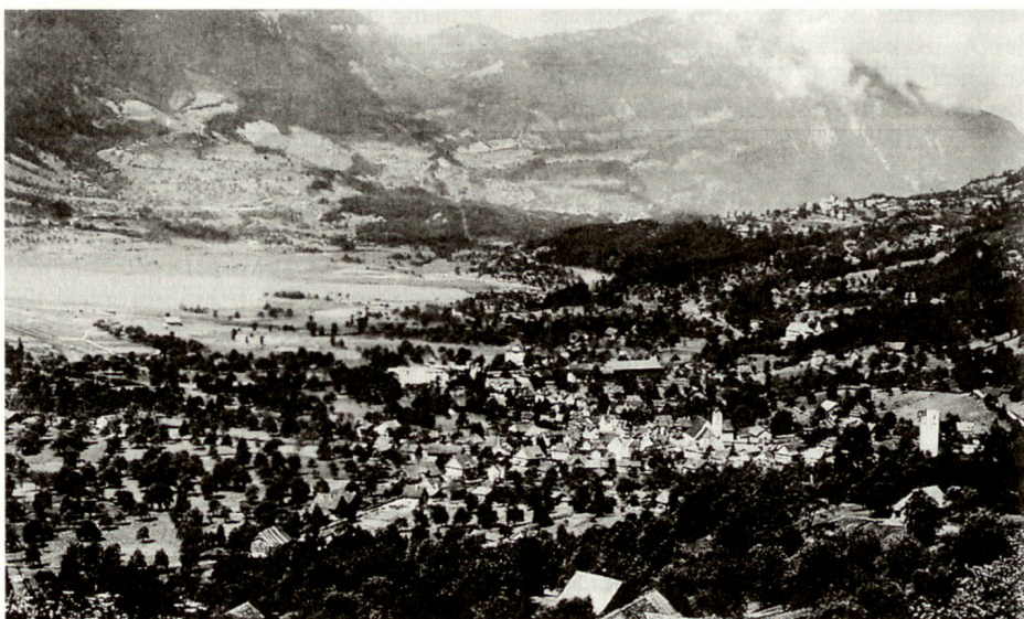
Steinen, Aufnahme aus den 1930er-Jahren, mit der damals schon herausragenden Obermühle. Fotos: Hans Rudolf Fuhrer
