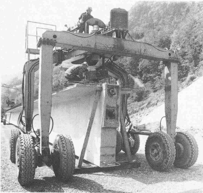
Bild 6. Transport eines rund 90 t schweren Trägers mit den «Elephanten»
