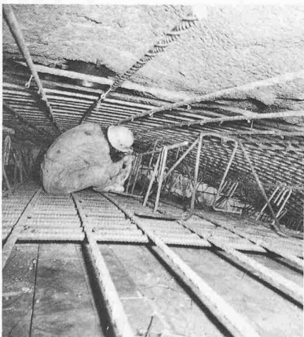
Bild 14. Scheitelarmierung des Innengewölbes Lüftungszentrale Huttegg
