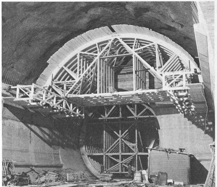
Bild 15. Freitragende Gewölbeschaltung Lüftungszentrale Huttegg
