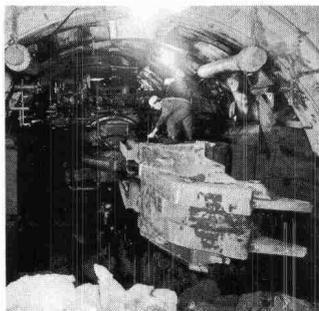
Unterhaltungsarbeiten am «Excavator» der Tunnelbauausrüstung Memco. Der gigantische, schaufelförmige «Reisszahn» ist Bestandteil einer Vortriebseinrichtung, die nach dem Schildsy-
