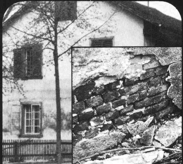
Renescan-Injektionen gegen aufsteigende Feuchtigkeit
