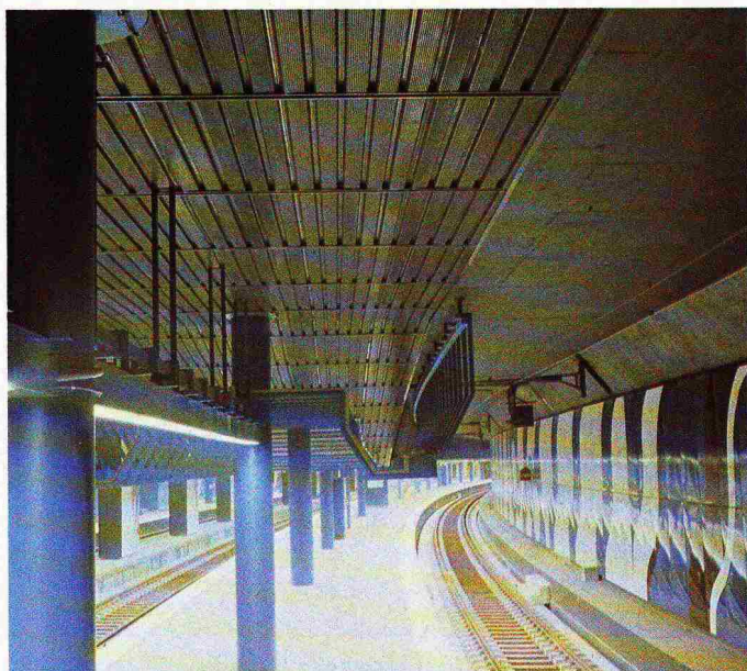
Bild 3. Perrongeschoss mit Vollstahlstützen
