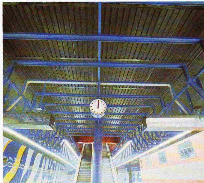
Bild 4. Rippenkonstruktion über dem Perrongeschoss
