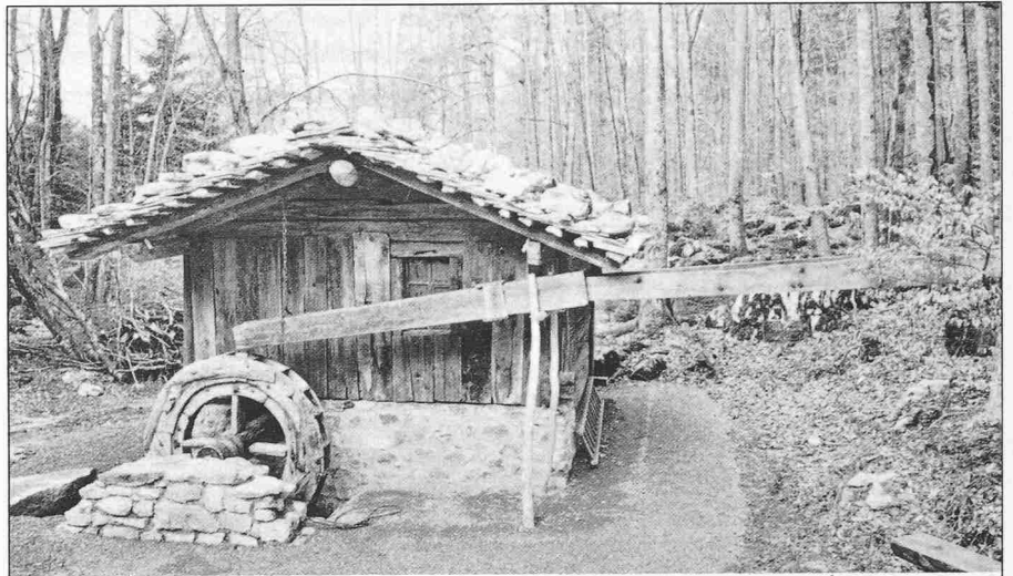
Wassergetriebene Leinsamenstampfe aus Curaglia (GR). In der Kammer befinden sich Gegenstände des ländlichen Gewerbes
