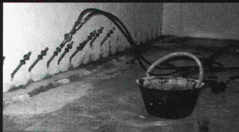
Elastische Abdichtungs-Injektion-Rascoflex in einer Zivilschutzanlage.
