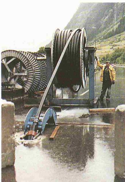
Bild 15. Vorspannung Überbau, Einziehen der Kabel Bildautor: K. Lüpold VSL
