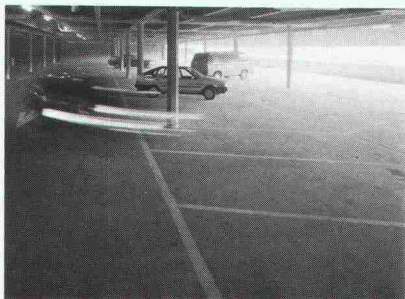
Parkdeck Glattzentrum, Wallisellen
