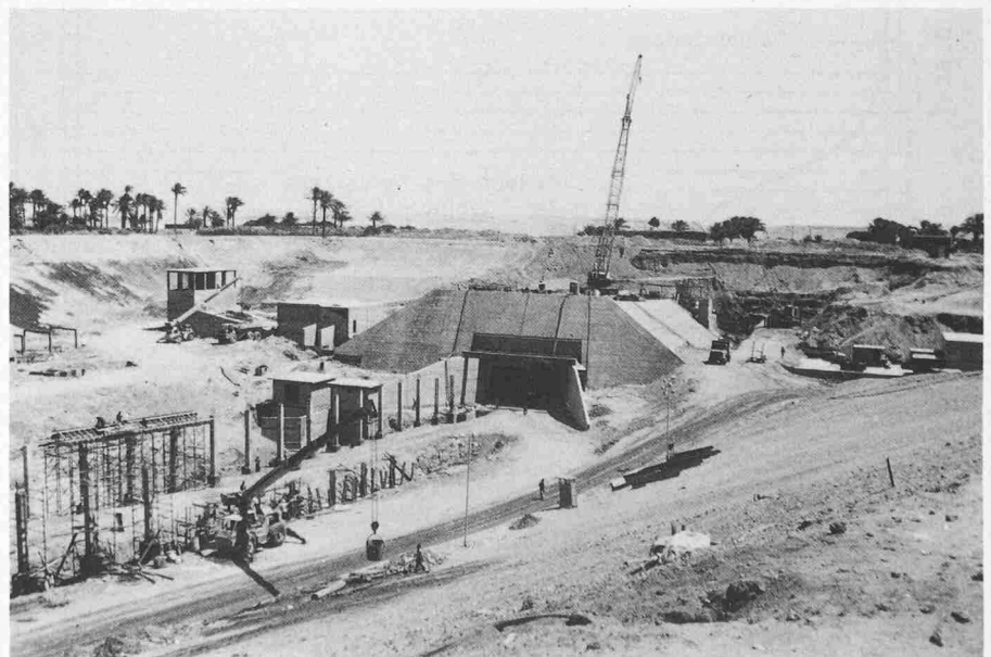
Bild 6. Westportal mit Lüftungsbauwerk
