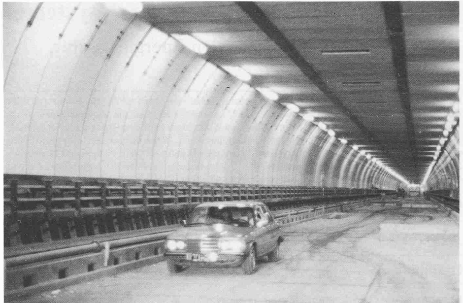
Bild 9. Tunnelröhre vor der Fertigstellung. Fahrbahndecke und Verkleidung der Gehwegkonstruktion fehlen noch
