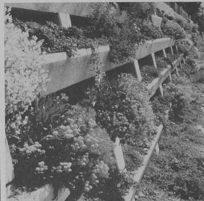
Detail aus einer bepflanzten Stützmauer
