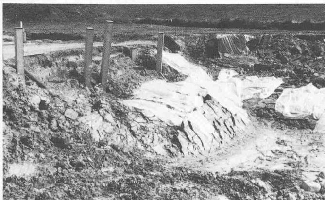
Bild 11. Baugrube Zürich, unmittelbar nach erfolgten Böschungsrutschungen. Man beachte das «Eintauchen» der Böschungsmasse in den Untergrund und die erhebliche rückwärtige Ausdehnung der Instabilität
