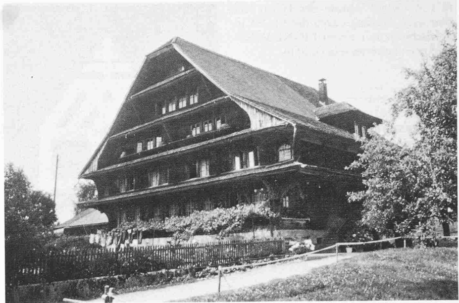
Bild 10. Konstruktiver Holzschutz an einem 200-jährigen Luzerner Bauernhaus
