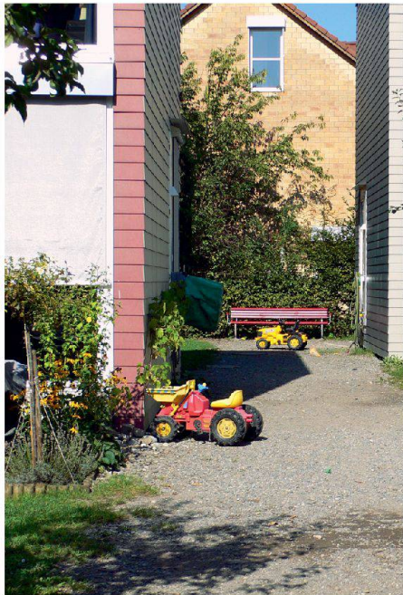
01 Die Wohnsiedlung Bachstrasse in Suhr (Zimmermann Architekten, 1998) mit ihren zehn Einfamilienhäusern aus Holz enthält diverse Gemeinschaftsräume (Foto: Pet Zimmermann)
