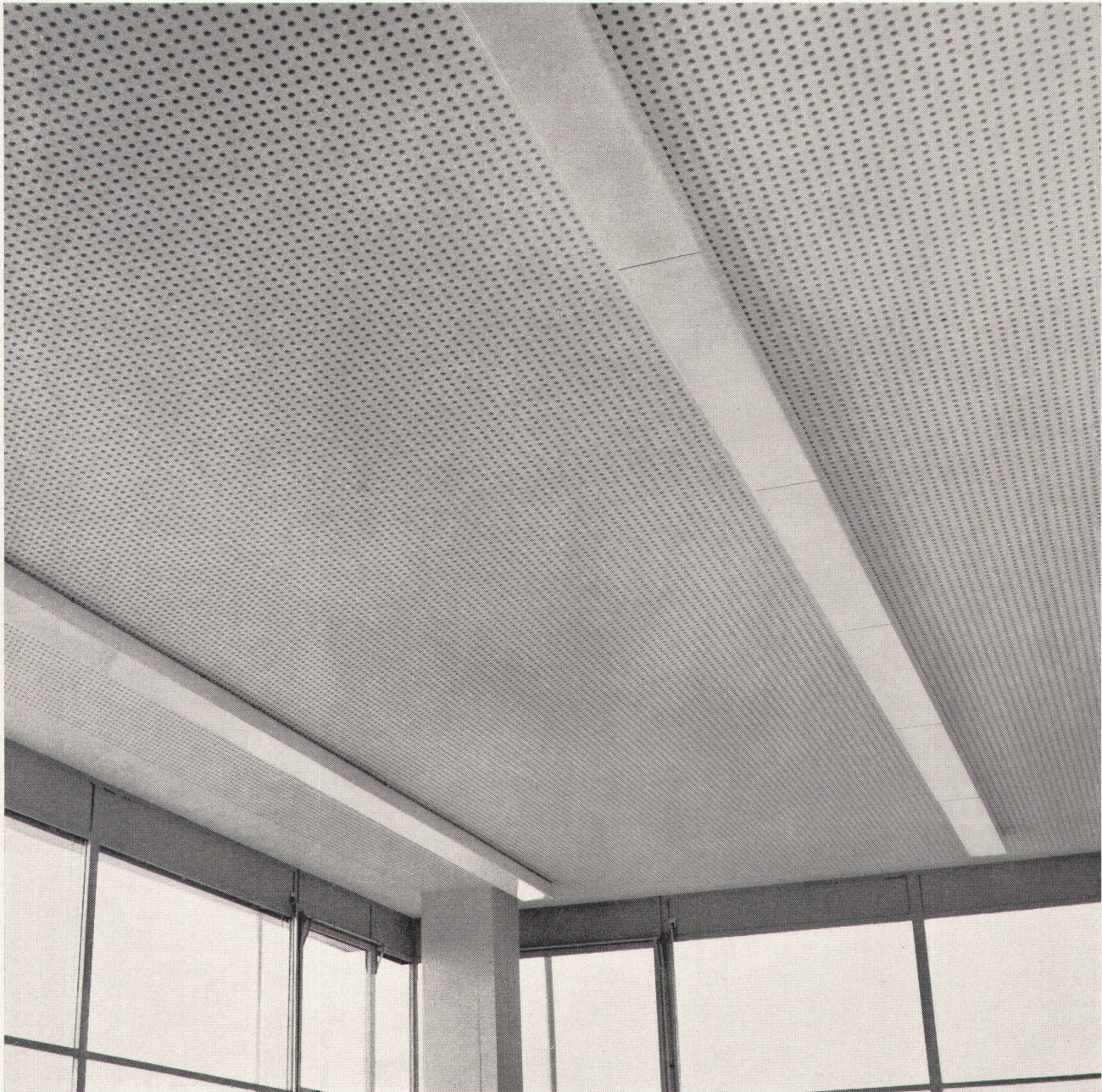
Fugenlose Schallschluckdecke aus Gitro-Platten
