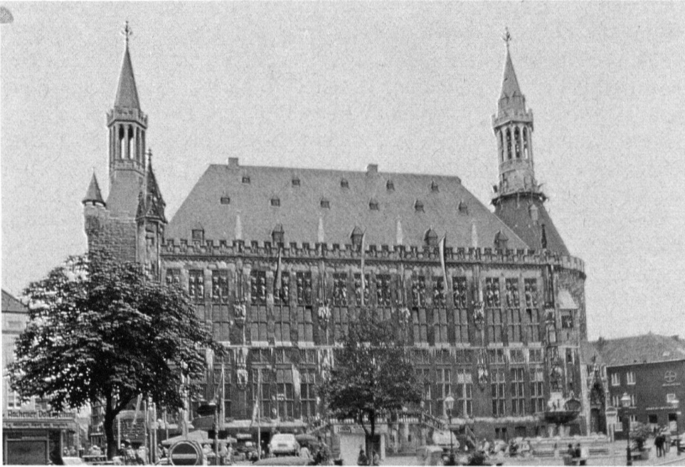
7 Rekonstruktion als nostalgischer Ersatz für die Suche nach neuen Formen: Die gotischen Turmhelme verlor das Aachener Rathaus bereits im Stadtbrand von 1656. Sie wurden vor wenigen Jahren nach alten Ansichten rekonstruiert.
